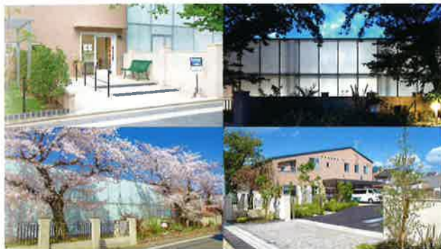
写3 整備後（若杉 外観）
